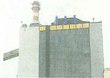
Bald wird das ÖDK-Gebäude dem Erdboden gleichgemacht HAIDER
